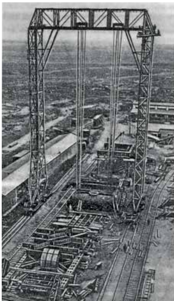
Портальный кран для монтажа котлов и металлоконструкций главного корпуса
