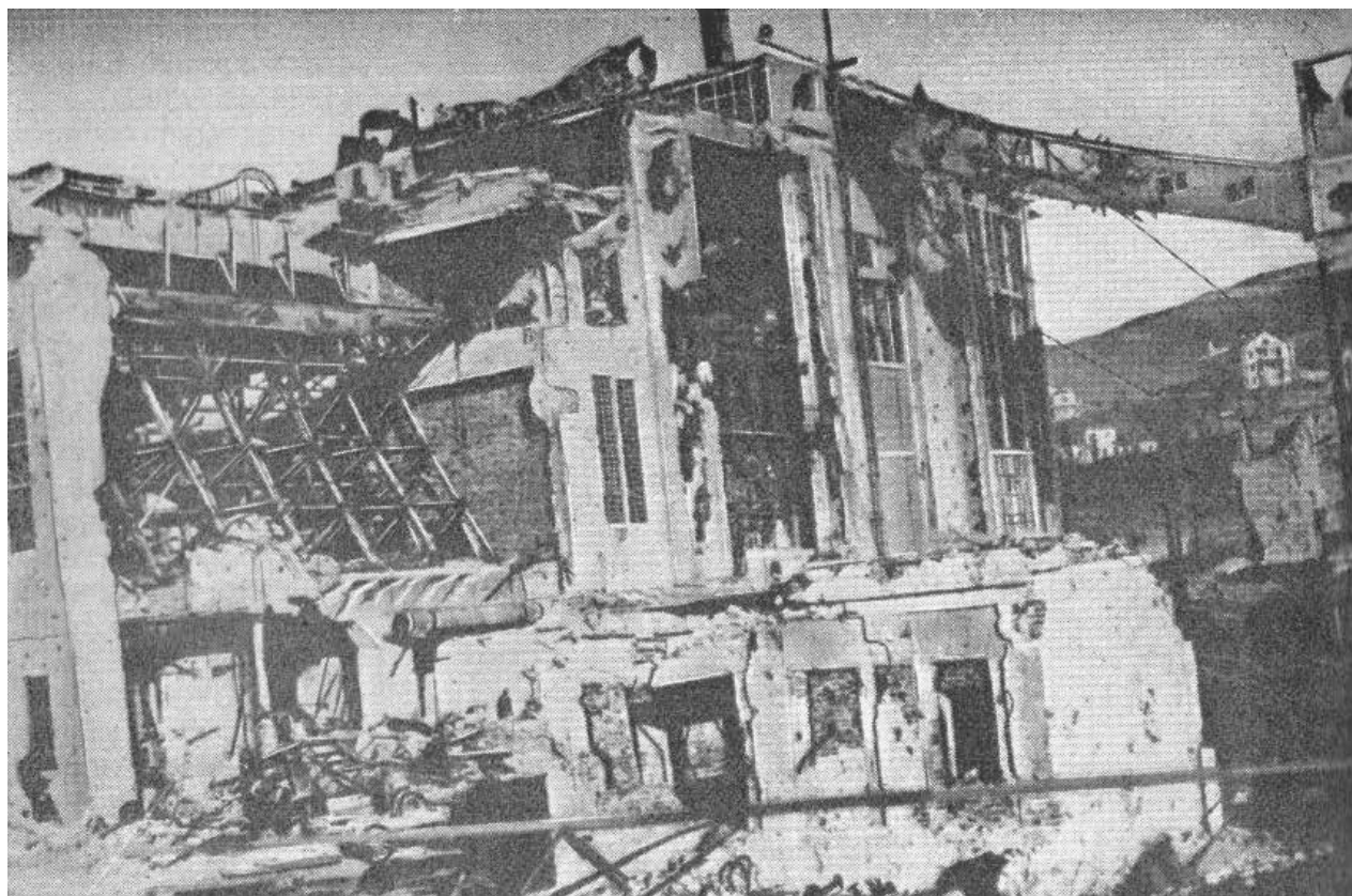
Разрушенная Новороссийская ГРЭС. 1943 год
